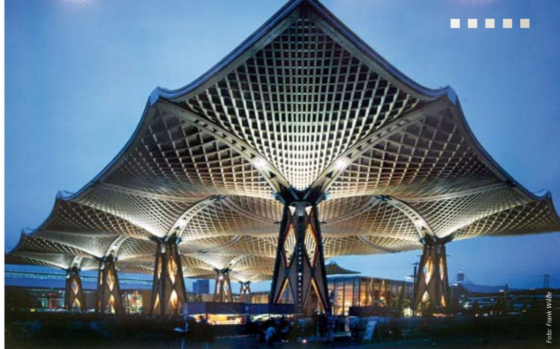
Nachhaltiges Bauen: Das größte freitragende, von Weißtannen gestützte Holzdach der Welt bleibt als Wahrzeichen der EXPO 2000.
